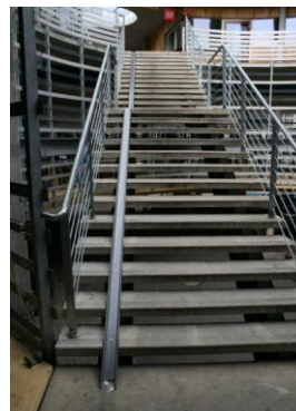
Zdjęcie 14: Rampa rowerowa na schodach
