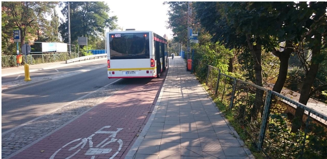
Zdjęcie 10: droga rowerowa przecinające zatoczkę autobusową (Miasto Tczew)
